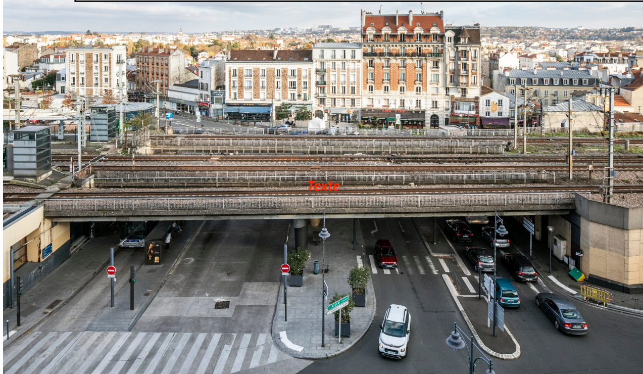
Vue aérienne de la gare du RER E Nogent - Le Perreux
