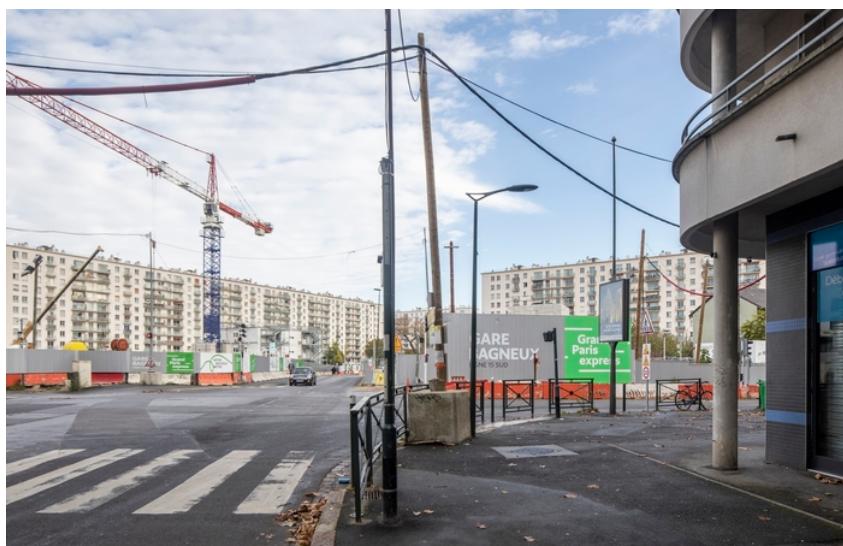
Quartier de la future gare Bagneux du Grand Paris Express
